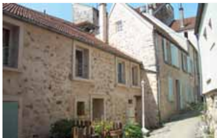
Logement à Palaiseau dans l'Essonne
