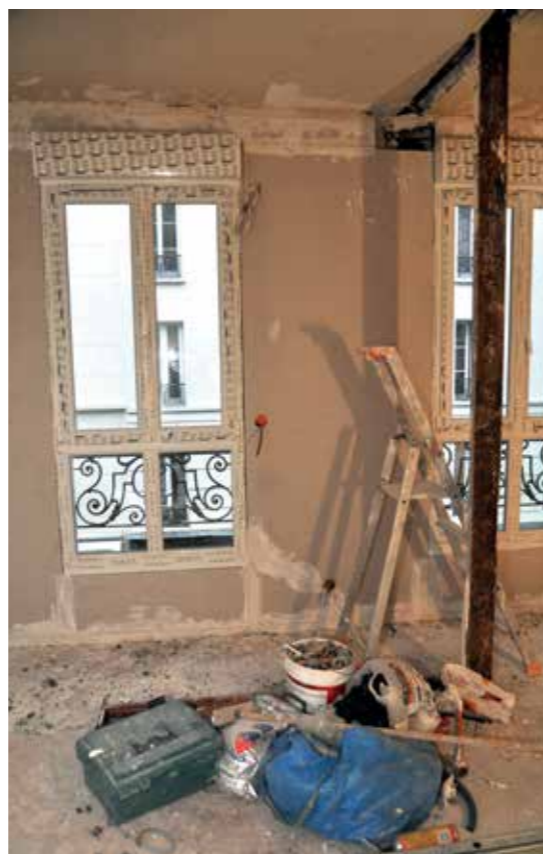
Logement en rénovation à Paris
