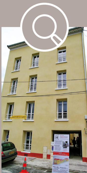
Logements S 1 -Maure-des-Fossés (SNL 94)
