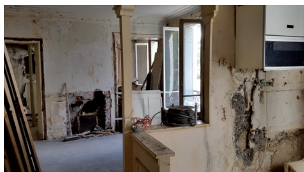
> Durant les travaux
